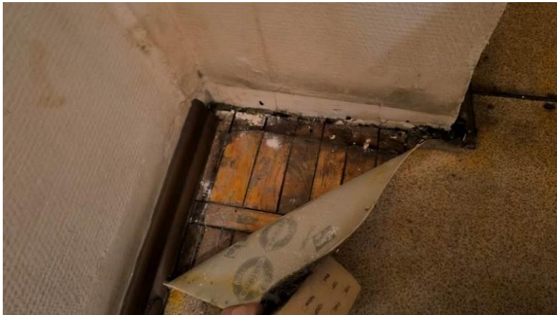
Рис. 84. Гниение дощатого пола в коридорах
