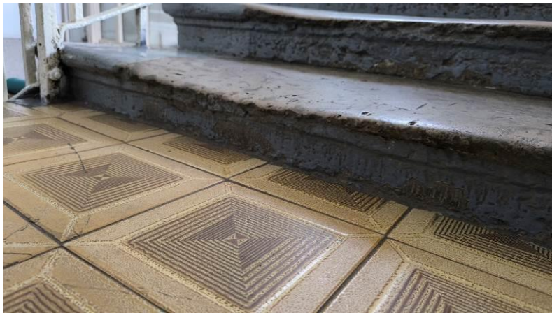
Рис. 85. Износ ступеней
