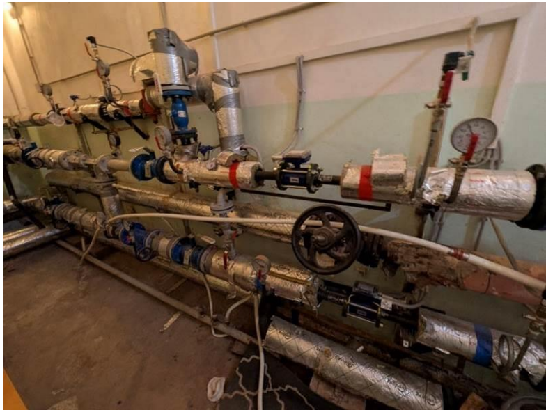
Рис. 95. Общий вид узла учёта тепловой энергии системы отопления и ГВС.
