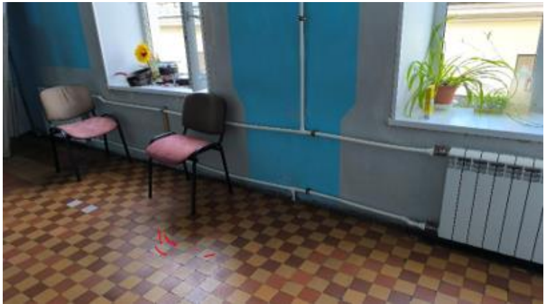
Рис. 76. Трещины по плитке кухни, помещение по плану №54, 3 этажа помещения 8-Н
