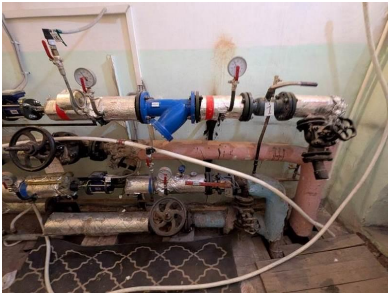
Рис. 94. Помещение ИТП, ввод трубопроводов системы отопления
